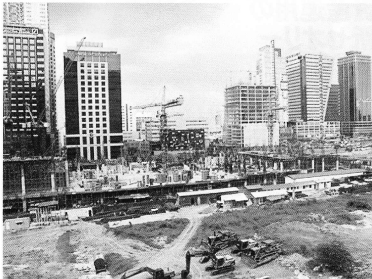
基地跡地を再開発したマニラ首都圏の「グローバルシティ」では、マンションやオフィスビルの建設ラッシュだ
