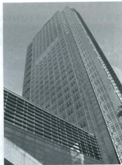
マニラのマカティ市に威容を誇るアヤラ・グループ本社ビル
